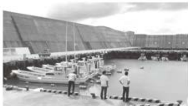
1 南大東漁港（北大東地区）平成20年から着工し平成31年2月に完成。岩盤掘り込み式漁港。クレーンによる漁船のつり上げ、降ろしをせず、何時でも出入港できるようになり、2020年には漁獲量は3倍に増え、水産業振興、観光にも大きな役割を果たしている。
