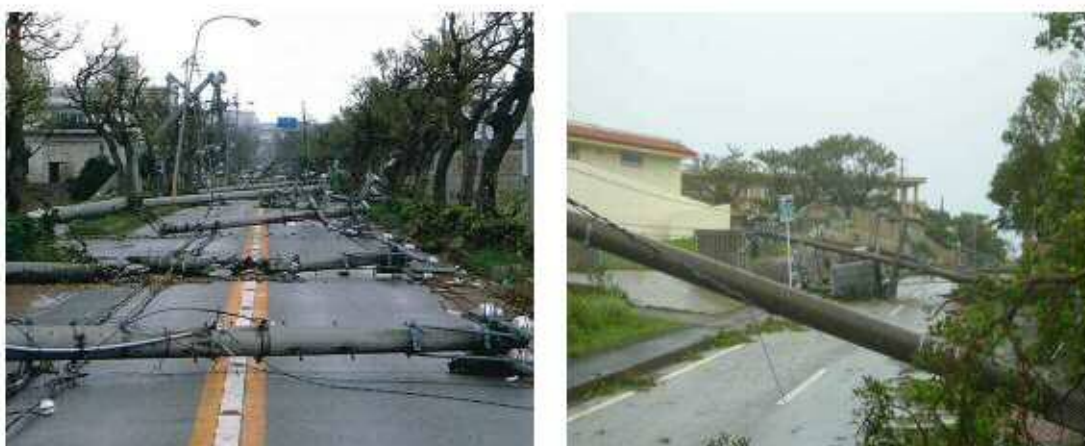
写真－1 台風による電柱倒壊状況
