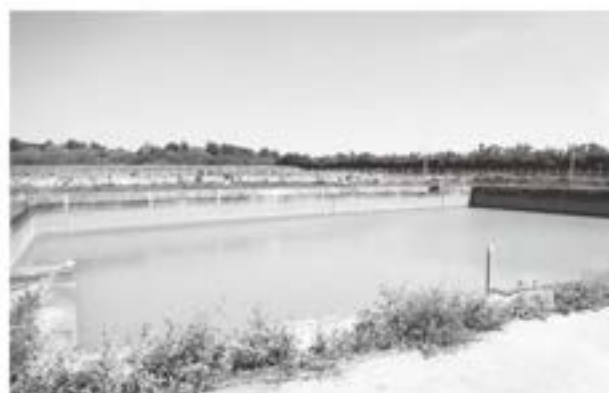
寄草地区第3号貯水池
