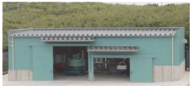
粟国村生ごみ処理施設
