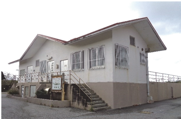
汚水処理施設
