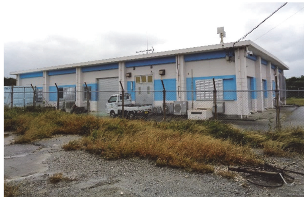
海水淡水化施設
