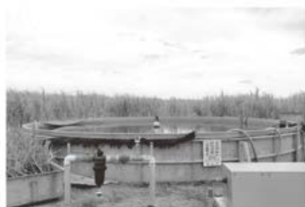
四志地区のマリンタンク
