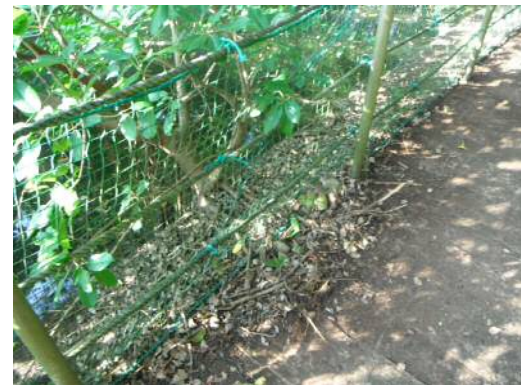
浮き桟橋床板に樹木が寄生
