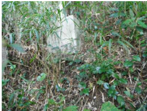
斜面地で基礎の移動
